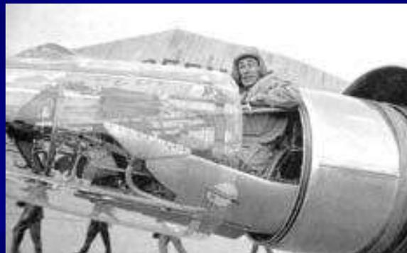
Yvan Littolff, pilote d'essais, dans le cockpit du Leduc 021, constitué d'un anneau de verre.
